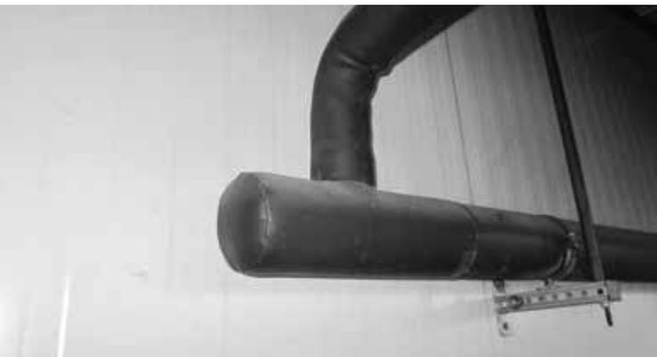
**Figura 16.** Aislamiento de tuberías en buenas condiciones.
